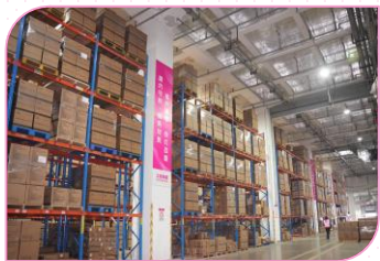
LED照明系统
