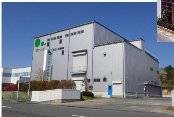
磐城总公司第2工厂大楼2（化妆品工厂）
