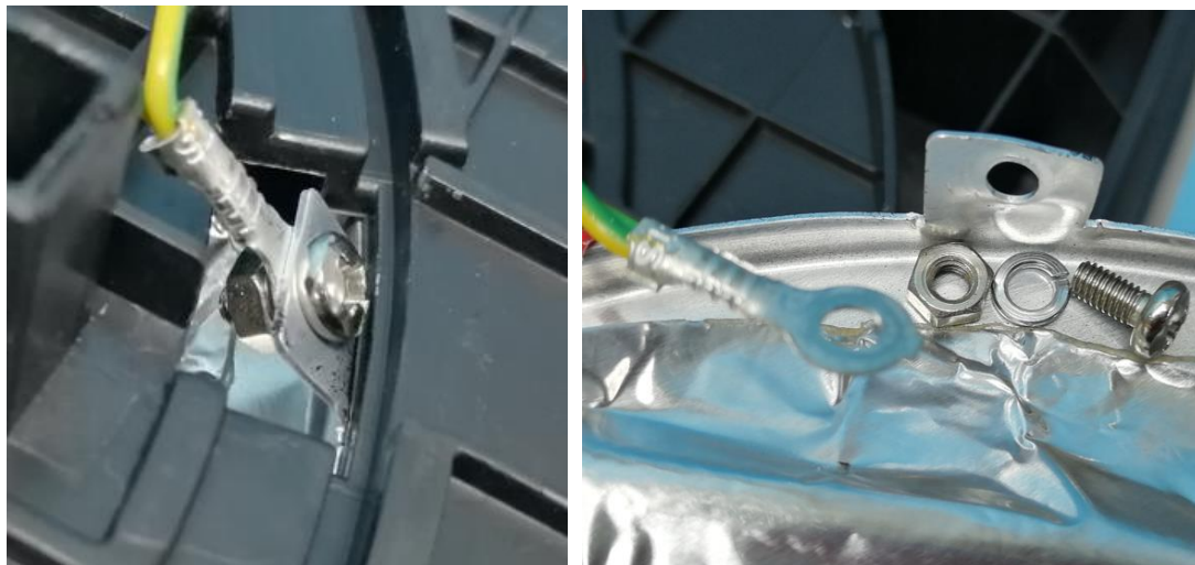
上盖金属接地
